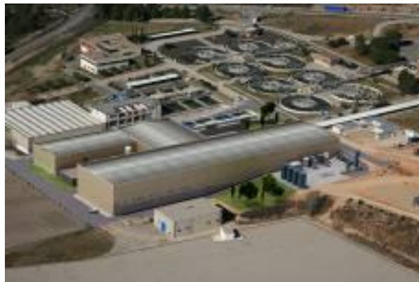
Figura 1. Planta potabilizadora de Abrera; 200,000 m 3 /día de desalación por EDR
